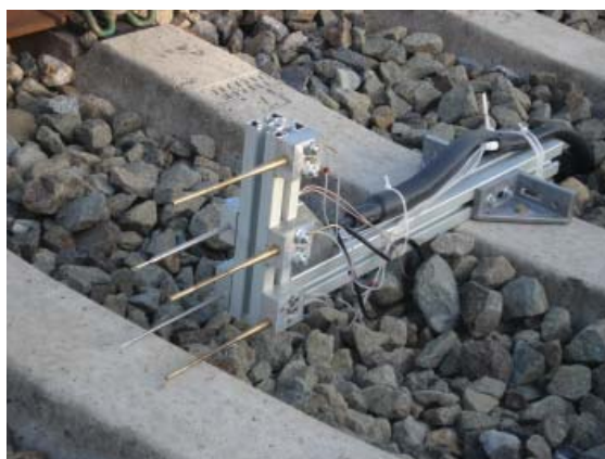
Pitots y anemómetro de hilo caliente instalados en la vía.
