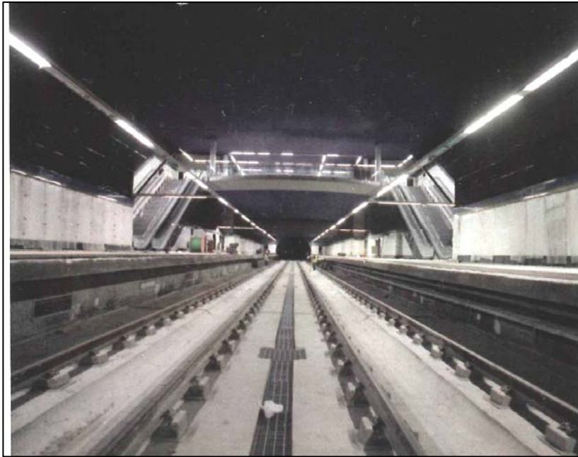
Estación de El Casar
