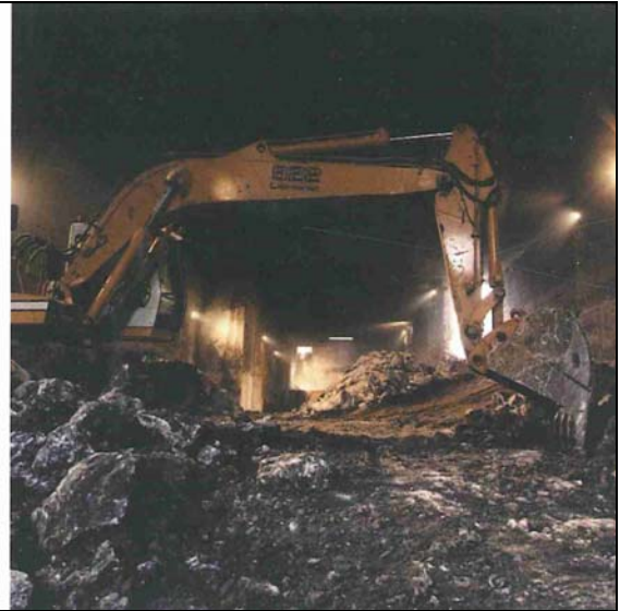
Excavación del recinto de la Estación de Los Espartales
