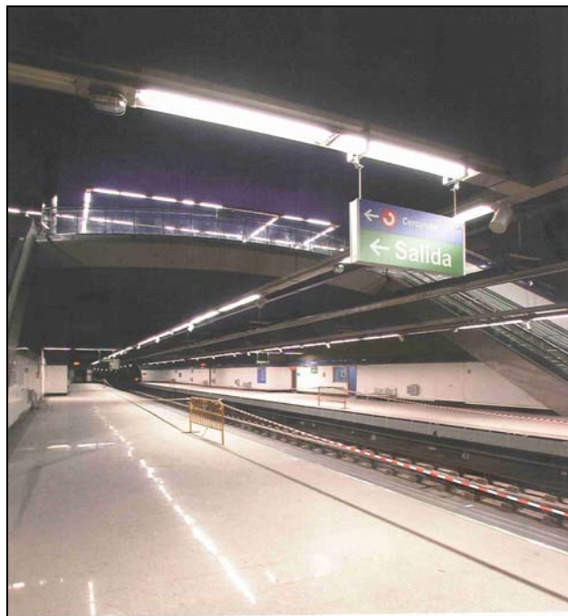
Estación de El Casar
