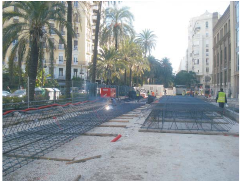
Ferrallado de armadura de muro pantalla
