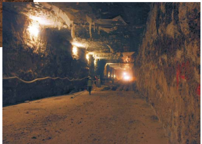
Excavaci3n del t3nel de lnea
