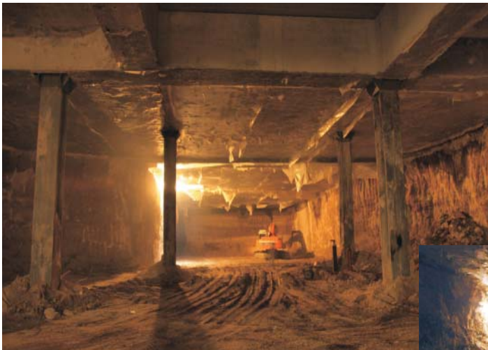
Excavaci3n de la Estaci3n de Alicante
